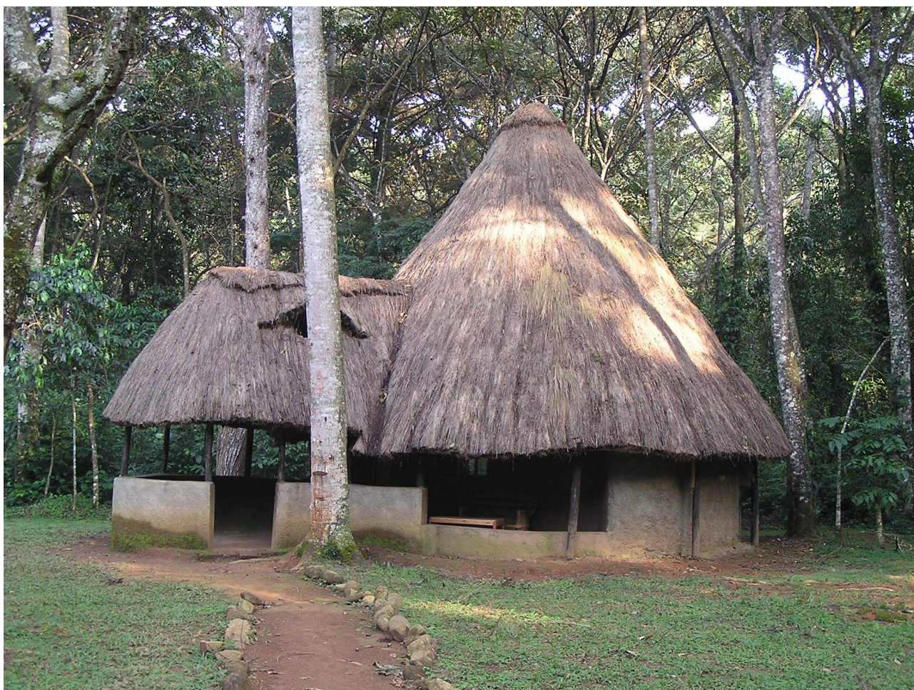
Domki kempingowy dla turystów zbudowane w tradycyjnej technologii.
