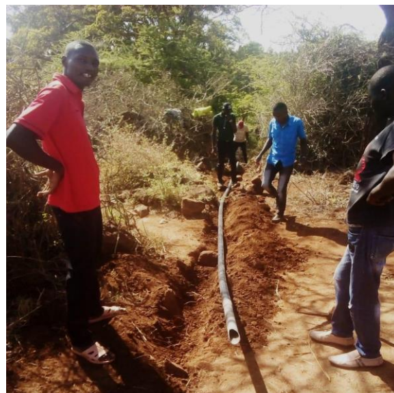
Ludzie instalują system nawadniania, hrabstwo Isiolo
